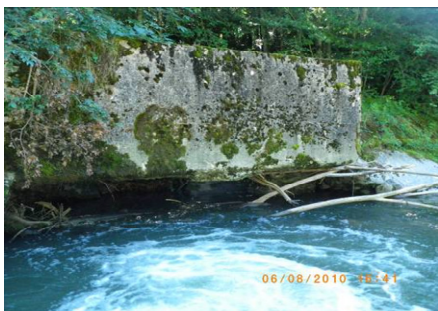
Affouillement du mur de soutènement en RG
